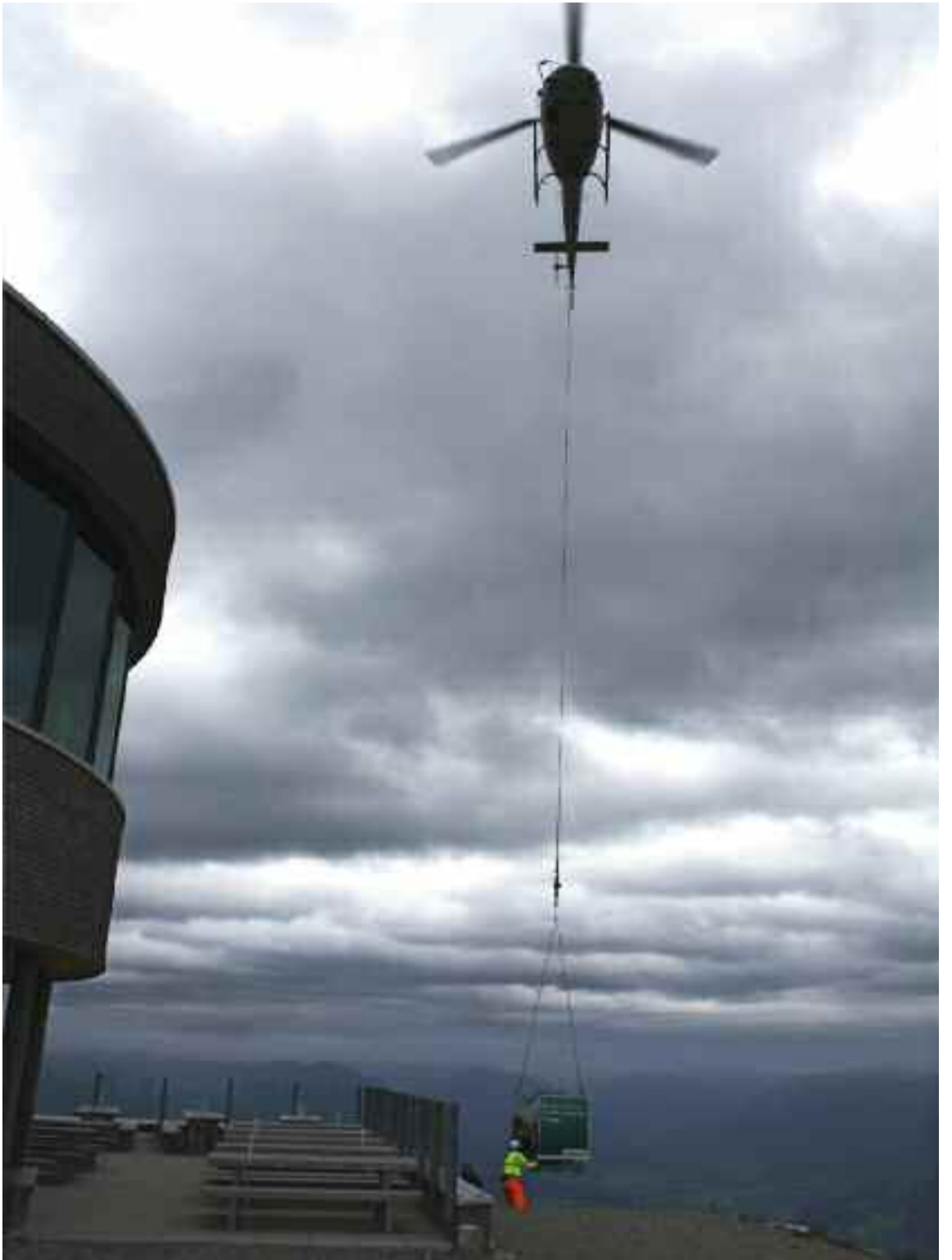
Gastank-Transport durch RHEIN HELI. Transport du réservoir de gaz par RHEIN HELI.
